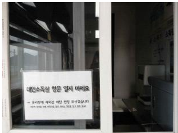
대인소독실이 근무자사무실과 맞닿아 있는 경우 자외선으로 인한 장기 근무자 건강이상 우려
