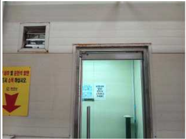
분무방식인 거점시설 경우 대인소독실 출입문이 100% 밀폐가 안되어 대인소독실을 통해 근무자 사무실까지 약품 새어나옴.
