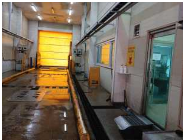
분무방식인 거점시설 경우 대인소독실 출입문이 100% 밀폐가 안되어 대인소독실을 통해 근무자 사무실까지 약품 새어나옴.
