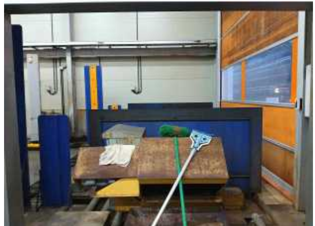
터널형 내부가 기계실과 오픈되어 연결되어있어서 소독효과 미비우려
