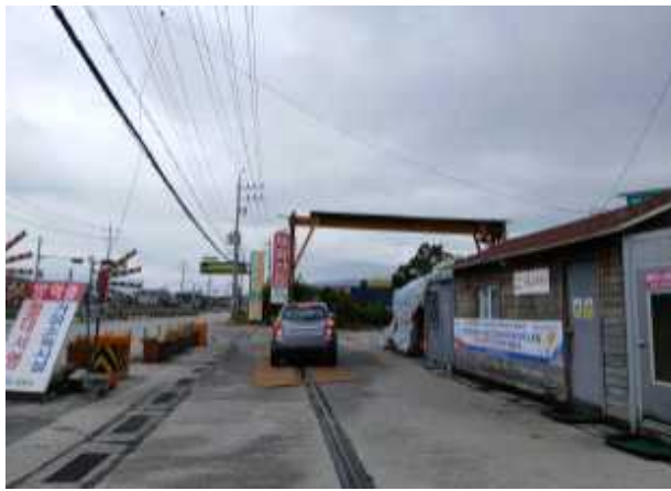
개방형 수동식 거점소독시설로 소독효과 미비, 밀폐형 구조로 전환 시급 소독폐수 자연방류로 인한 환경피해
