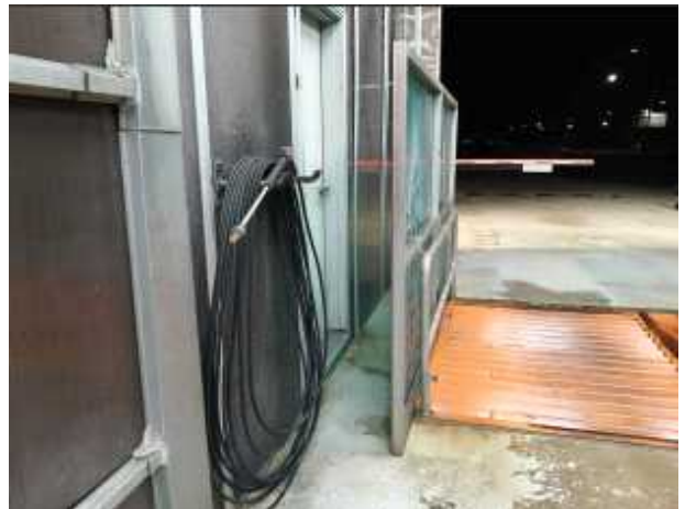
터널내부에 고압세척기 설치로 동절기 가축전염병 발생시 세륜이후에 2차로 차량외부 세척 추가실시가능. 터널내부 청소시 용이.
